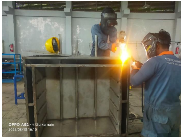
Gambar 6. Pemasangan dinding oven pengering ikan
