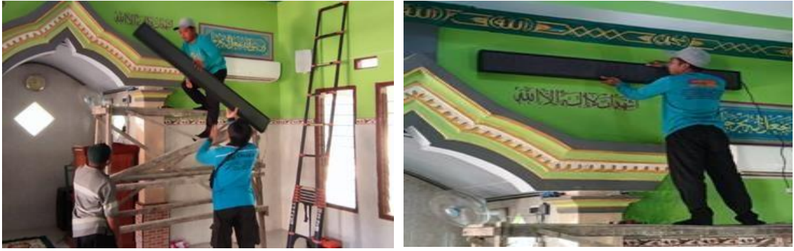
Gambar 3.1 Pemilihan Tempat Pemasangan Hardware
