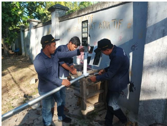
Gambar 3. Pemasangan unit lampu pada tiang
