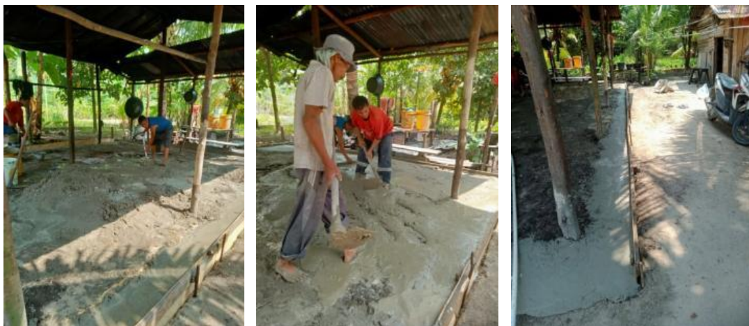
Gambar 6. Proses Pengerjaan Renovasi Rumah Produksi
