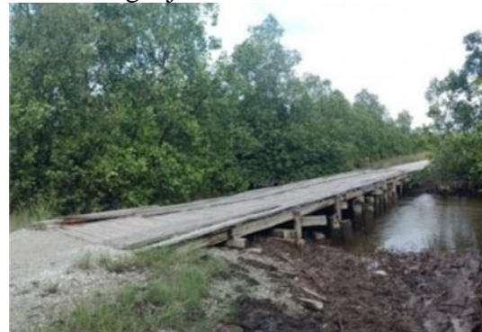
Gambar 1. Kondisi jembatan Sungai Jalan Antara
