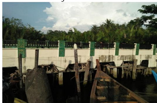
Gambar 1 Kondisi eksisting jembatan
