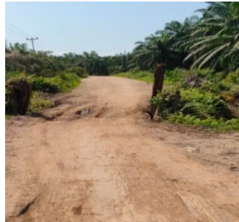
Gambar 2 Kondisi eksisting dilapangan
