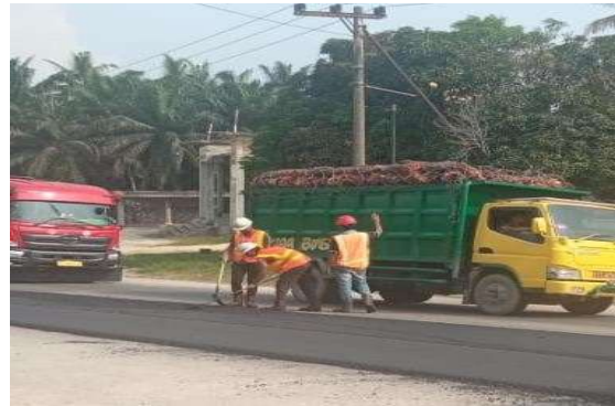
Gambar 12 Pengaturan Lalu Lintas dan Penggunaan Rompi
