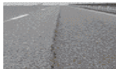
Gambar 4 Retak Memanjang
